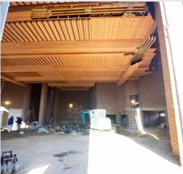
In das Kirchenschiff wurde ein zusätzliches Geschoss eingezogen.
