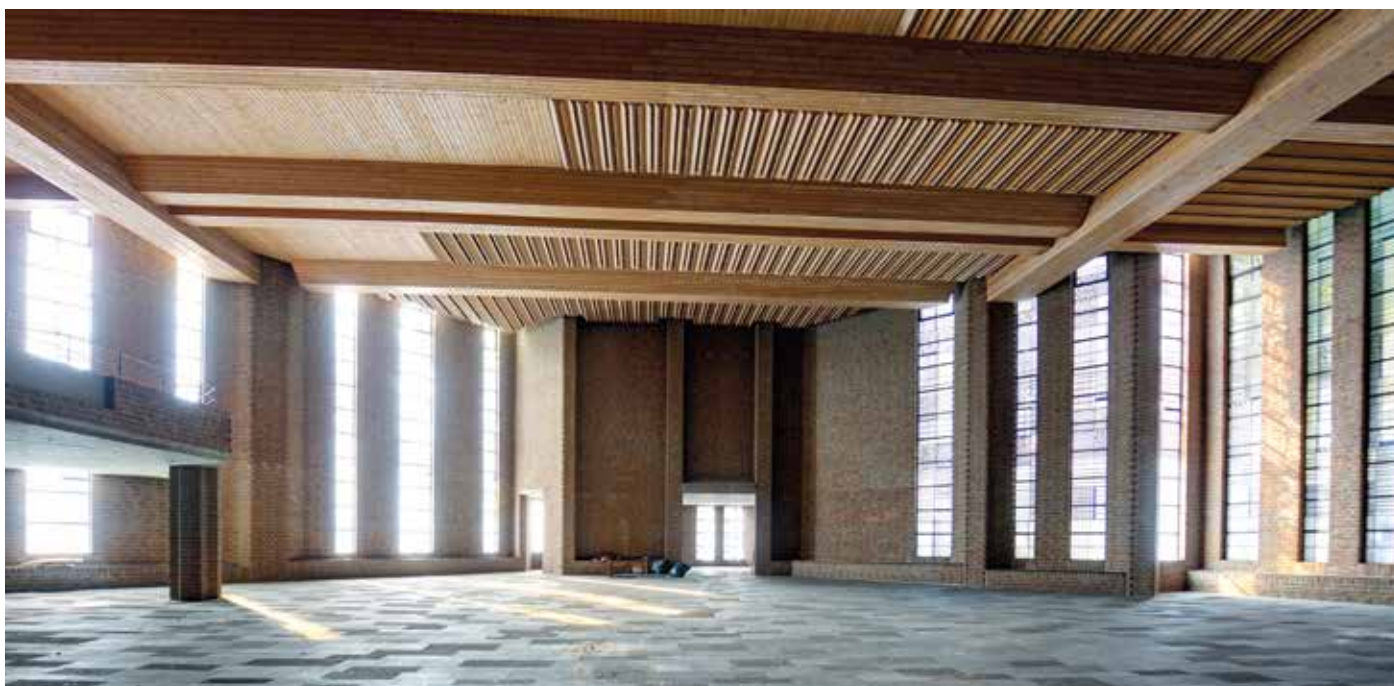
Die St. Laurentius Kirche in Holthausen wird zur Kita St. Laurentius.
